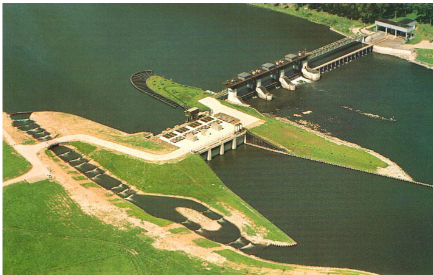
Figuur 1 Vistrap, waterkrachtcentrale en stuw in de Maas bij Linne (bron figuur: CADDET, 1995)
